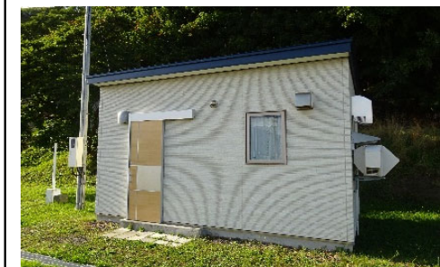
No.17：堀株守衛所待機所
