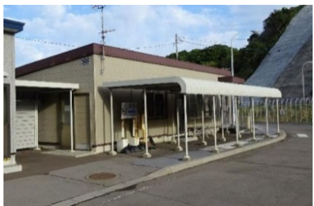
No.15：茶津守衛所本館
