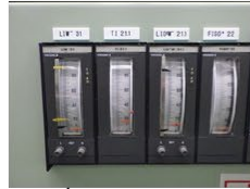
④温度指示計(制御盤)
