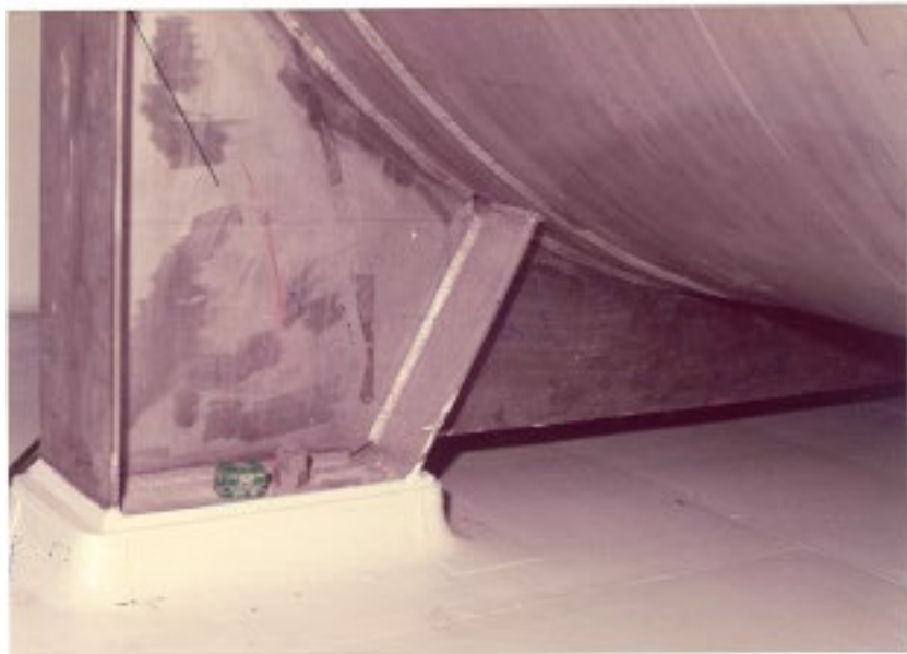
廃希釈剤貯槽（318V10）の下部
