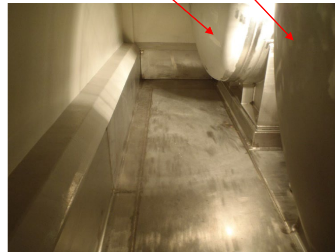
受入貯槽(328V10,328V11)周辺の状況
