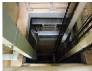
床 (カートン搬出リフトの開口部)
