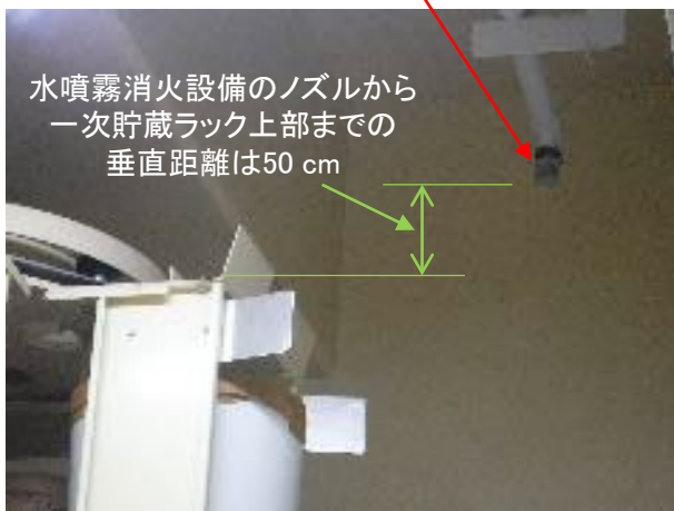
写真② カートン貯蔵施設(A001)の天井 (水噴霧ノズル)
