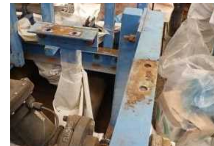
サポート部（配管取外後）
