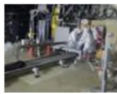
<貫通孔前での作業状況>
