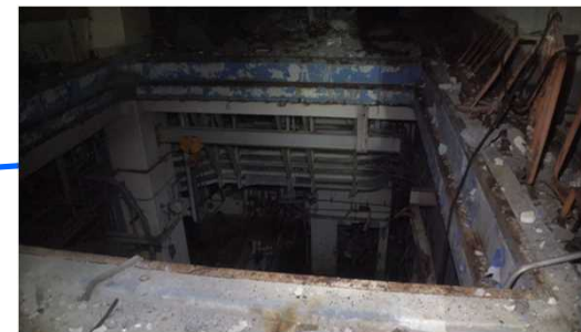
(大物搬入口付近の様子)
