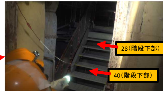
トラス室入口 (2022年12月22日原子力規制庁撮影)
