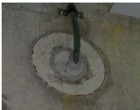
(写真は電線管の止水処置)
