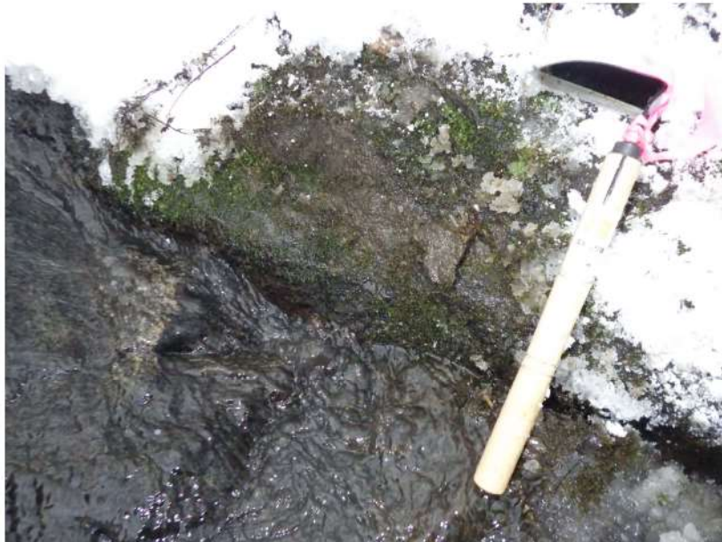
図 2.1.a.c-4 (20) 防潮堤（茶津側）露頭状況 P20 茶津川支流の溪床（P19 拡大） 凝灰岩（火山礫凝灰岩）が分布し，B 級からなる。
