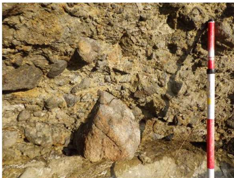
図 2.1.a.c-4 (4) 防潮堤（茶津側）露頭状況 P4 地山（海側）（P3 拡大） 凝灰角礫岩が分布し，B級からなる。
