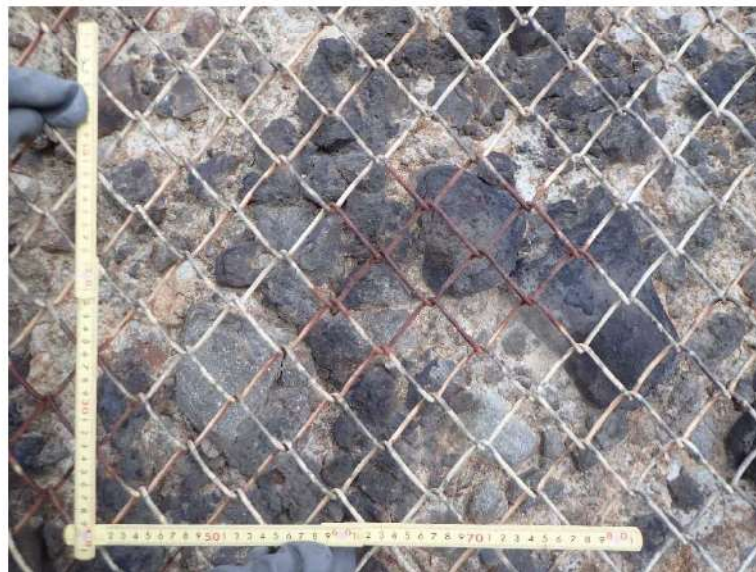
図 2.1.a.c-7 (2) 防潮堤（堀株側）露頭状況 P2 防潮堤擦り付け部（P1 拡大） 凝灰角礫岩が分布し、B 級からなる。
