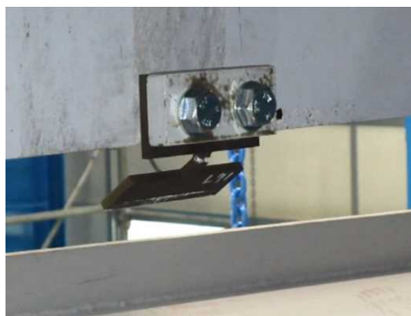
図 2-1 止板の固定状態及び開放後の状態
