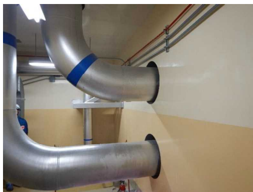
図3 貫通孔の隙間の例
