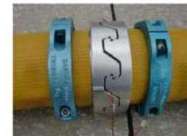
可搬型ホース（150A）接続後
