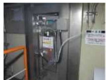
④ 復水ピット入口扉
