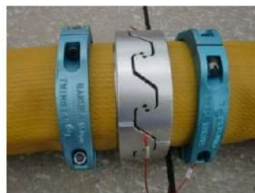
可搬型ホース（150A）接続後
