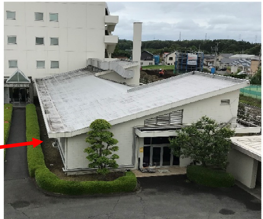
第一実験棟外観写真
