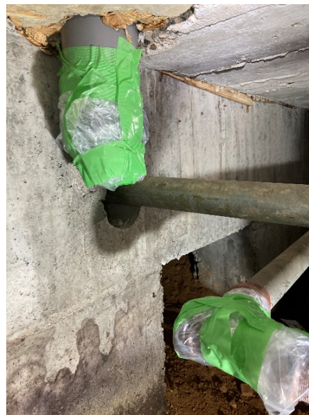
脱落箇所 B 養生後 (2022年8月8日実施)
