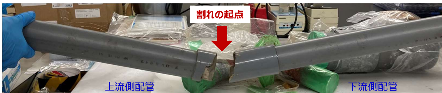
破断配管A 割れ方向のサンプルの状態再現
