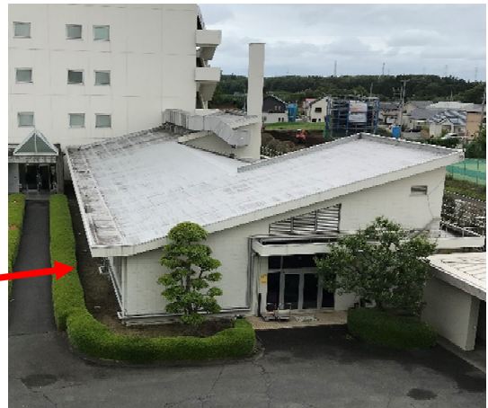
第一実験棟外観写真
