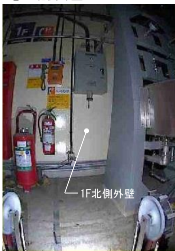
①1F北側外壁
