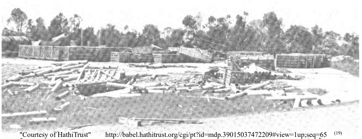
図29 Grand Gulf 原子力発電所資材置き場におけるパイプの散乱状況
