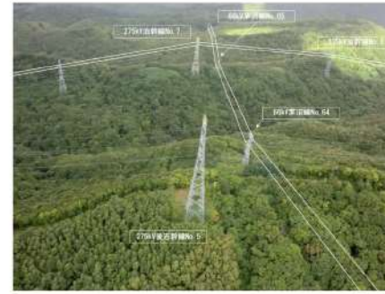
第2.2.3.5図 ③交差箇所の現地状況 (1/3)
