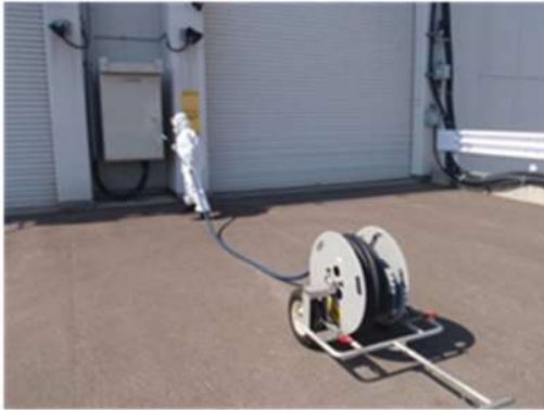
高圧ケーブル敷設 (屋外)
