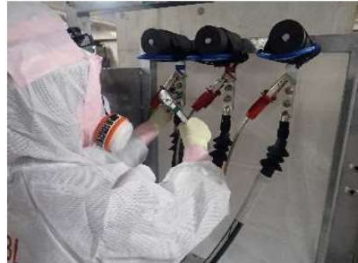
高圧ケーブル接続 (端子) (屋外) (作業風景は類似作業)
