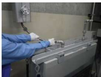
空冷配管との接続
