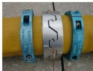
可搬型ホース(150A)接続後
