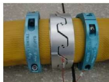
可搬型ホース(150A)接続後
