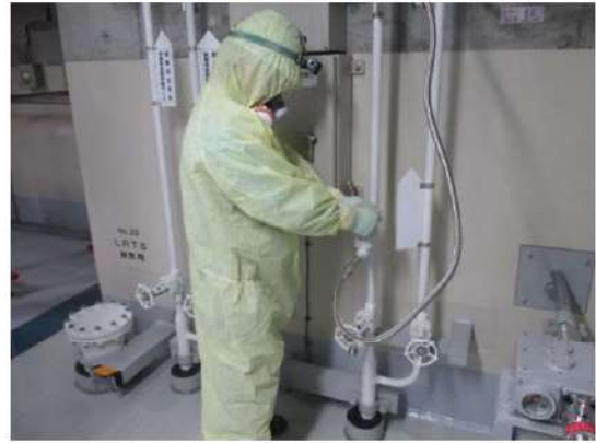
(制御用空気供給弁閉操作イメージ)
