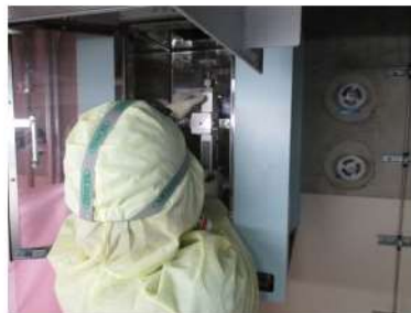
試料採取管によるガス採取 (周辺補機棟 T. P. 28.7m)
