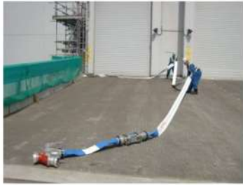
可搬型ホース敷設 (屋外)
