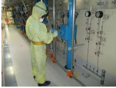
補機冷却水（海水）通水系統構成 （原子炉補助建屋 T. P. 10. 3m）
