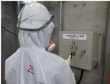
SG 直接給水用高圧ポンプ起動操作 (周辺補機棟 T.P. 24. 8m)
