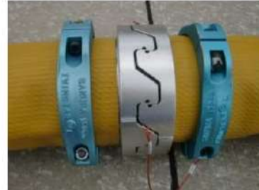
可搬型ホース (150A) 接続後
