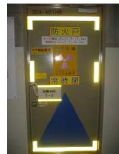
図 16 扉への反射テープ貼り付け例
