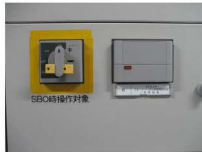
図 14 操作対象機器への反射テープ貼り付け例
