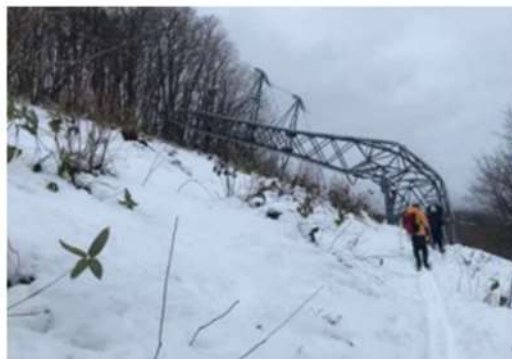
大雪による鉄塔倒壊事例 ※3
