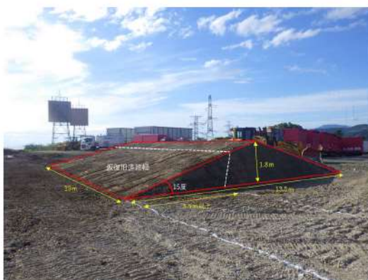
第3図 斜面崩壊後を模擬した土砂
