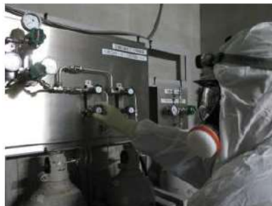
【図3 原子炉補機冷却水サージタンク加圧操作風景】
