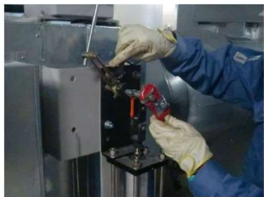
(空気作動ダンパ開作業イメージ)
