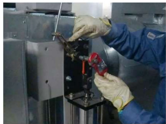
(空気作動ダンパ閉作業イメージ)
