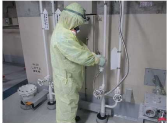
(制御用空気供給弁閉操作イメージ)
