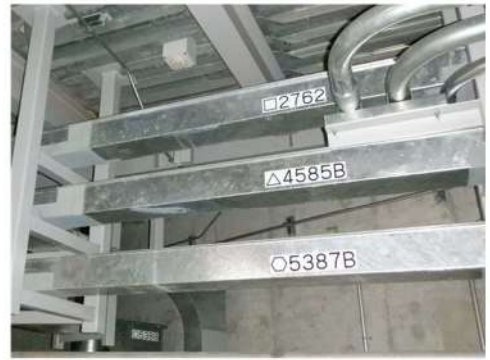
ケーブルトレイ，電線管の例
