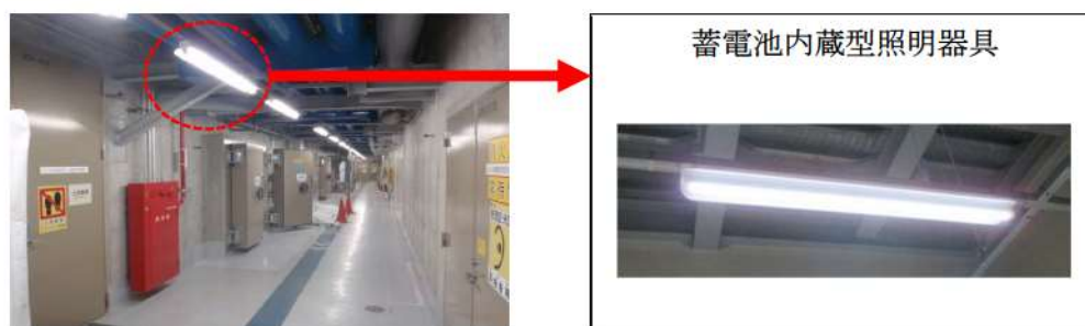
第 41-1-21 図：消火用非常用照明の設置例
