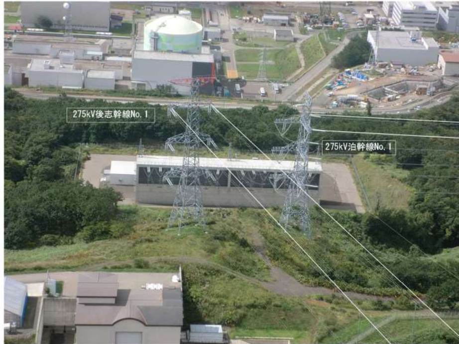
第 2.2.3.3 図 ①近接箇所の現地状況 (1/3)
