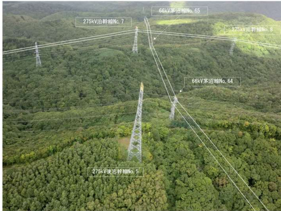
第 2. 2. 3. 5 図 ③交差箇所の現地状況 (1/3)
