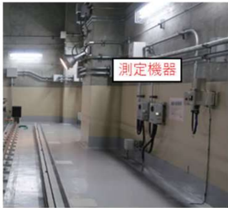
⑦使用済燃料ピット周り
