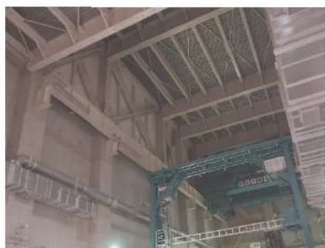
図 5.2.2 燃料取扱棟の屋根
