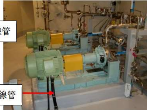
機器へのケーブル取合い状況 (格納容器冷却材ドレンポンプとの取合い)
