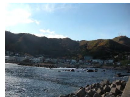
既に地すべり後の凹地形を呈している
