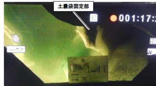
劣化土嚢袋（吸引中）の状況
