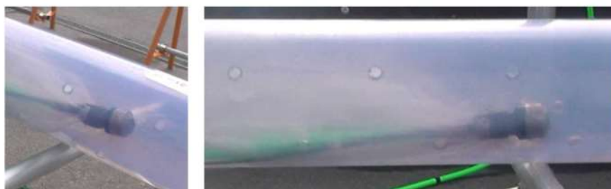
添付 5-4(4) 図 管内清掃装置進行時の様子
