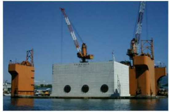
【建設時（曳航前）】放水池ケーソン部に内蔵された放水口
