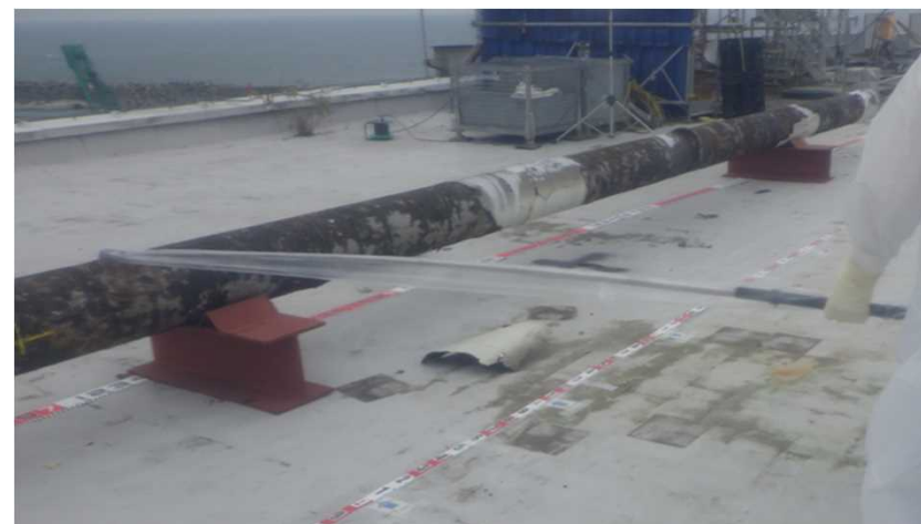
測定状況(配管上面)
