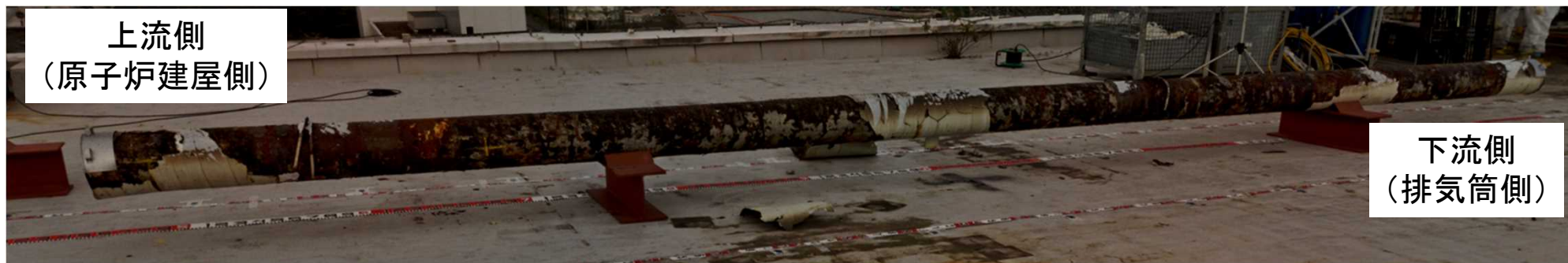
測定実施方向から見た全景
