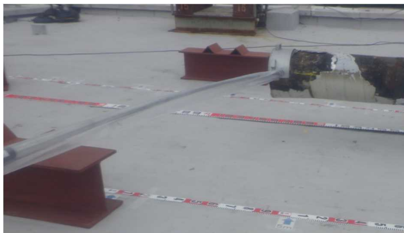
測定状況(配管前面)
