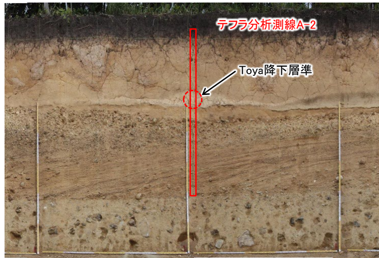
図(1.2) 法面④詳細画像
