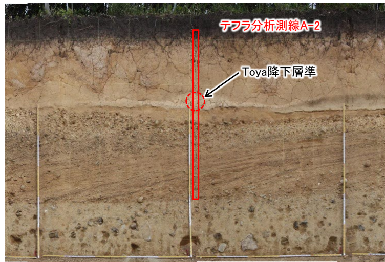
図(1.2) 法面④詳細画像
