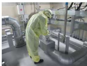
可搬型大型送水ポンプ車による原子炉容器への注水系統構成 (運転員 (現場) B) (原子炉補助建屋 T.P. 10.3m (中間床))
