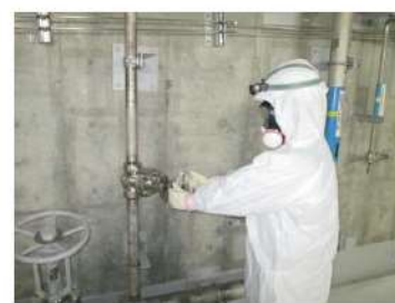
可搬型大型送水ポンプ車による 原子炉容器への注水 系統構成 (運転員 (現場) C) (周辺補機棟 T.P. 10.3m)
