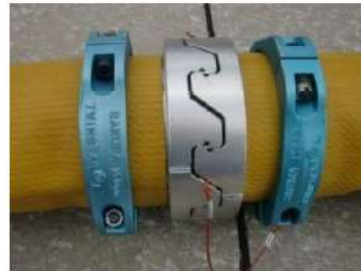
可搬型ホース (150A) 接続後
