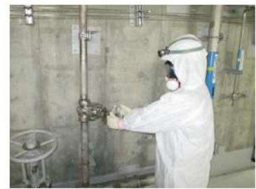
可搬型大型送水ポンプ車による原子炉容器への注水系統構成 (運転員 (現場) C) (周辺補機棟 T.P. 10.3m)
