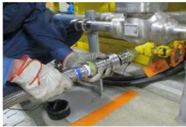
ホース接続操作（油タンク側） （周辺補機棟 T. P. 10. 3m）
