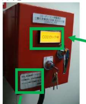
写真③ 放出ロック盤
