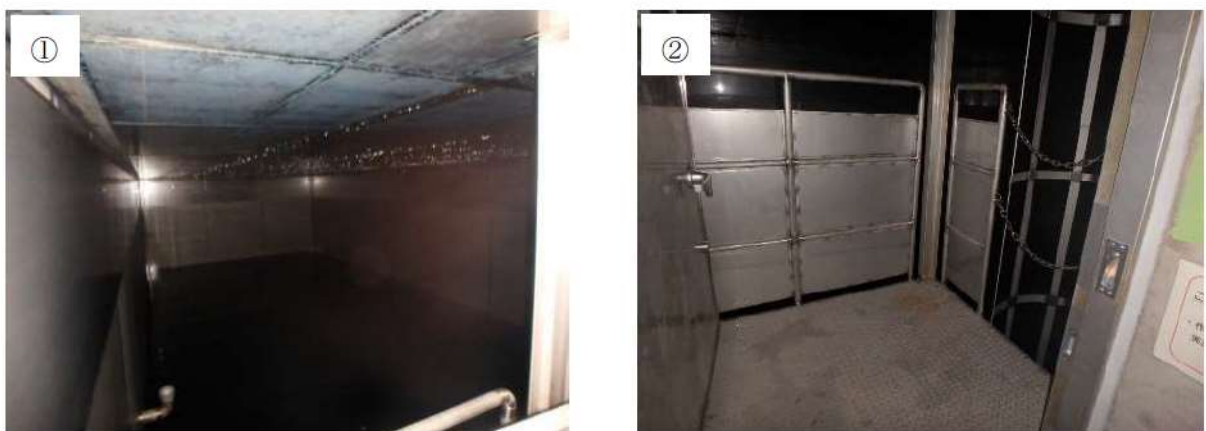
第 5-7 図：補助給水ピットの現場状況
