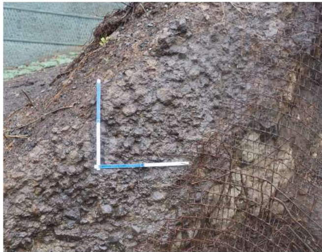
図 2.1.a.c-4 (2) 防潮堤（茶津側）露頭状況 P2 防潮堤擦り付け部近景（P1 拡大） 凝灰角礫岩が分布し，C 級からなる。
