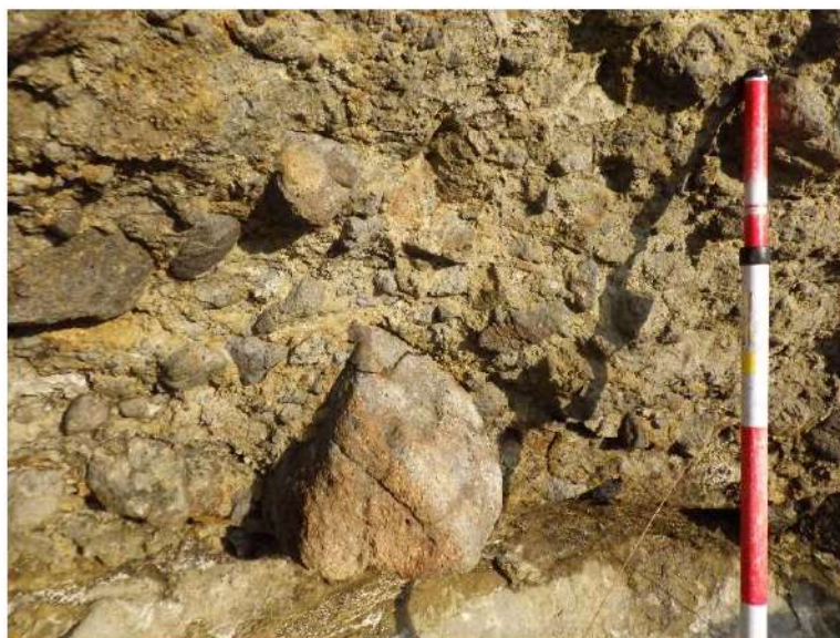
図 2.1.a.c-4 (4) 防潮堤（茶津側）露頭状況 P4 地山（海側）（P3 拡大） 凝灰角礫岩が分布し，B級からなる。
