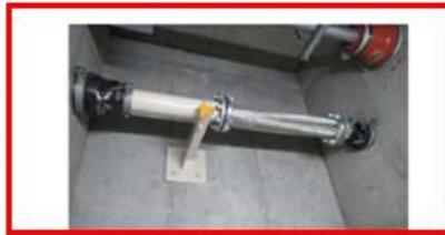
第1-35図：地盤変位対策の実施例
