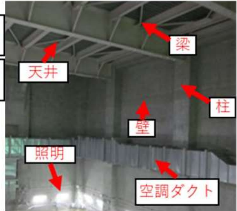
②使用済燃料ピット上部
