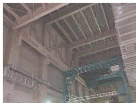
図 5.2.2 燃料取扱棟の屋根
