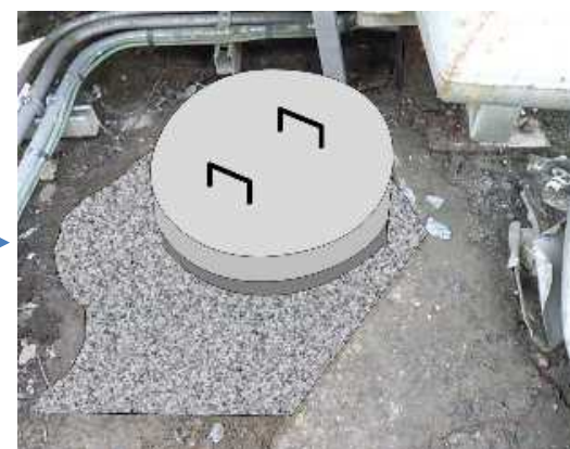
③舗装材で周辺を固める。
