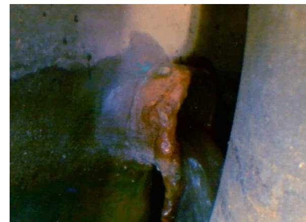
ピット南東側壁に確認された配管からの流入状況（散水中） 3
