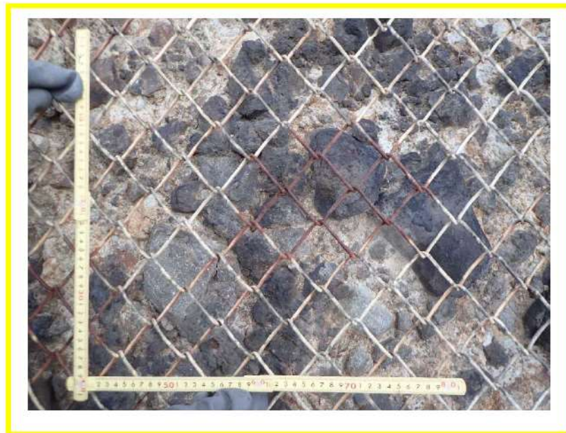
図 2.1.a.c-7 (2) 防潮堤（堀株側）露頭状況 P2 防潮堤擦り付け部（P1 拡大） 凝灰角礫岩が分布し，B 級からなる。
