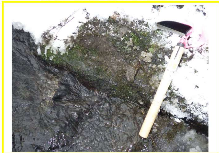
図 2.1.a.c-4 (20) 防潮堤（茶津側）露頭状況 P20 茶津川支流の溪床（P19 拡大） 凝灰岩（火山礫凝灰岩）が分布し，B 級からなる。
