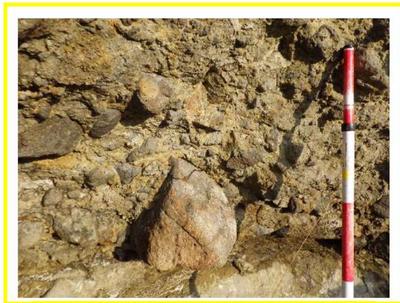
図 2.1.a.c-4 (4) 防潮堤（茶津側）露頭状況 P4 地山（海側）（P3 拡大） 凝灰角礫岩が分布し，B級からなる。
