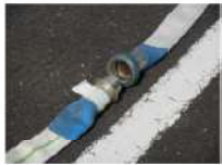
③ 可搬型ホース接続前
