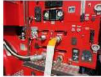
② ポンプ車へ吐出ホース接続後
