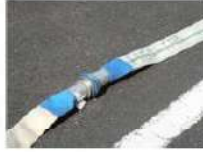
④ 可搬型ホース接続後
