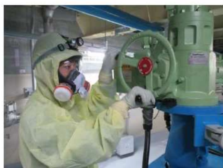
1 次冷却材ポンプ封水ライン隔離弁 閉止操作 （周辺補機棟 T.P. 17.8m（中間床））
