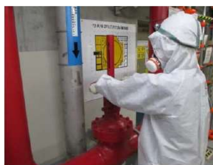
消火ポンプによる原子炉容器への注水系統構成 (運転員 (現場) C) (周辺補機棟 T. P. 17. 8m)
