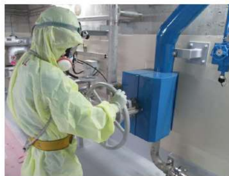
B-充てんポンプ自己冷却運転系統構成 （原子炉補助建屋 T.P. 10. 3m（中間床））
