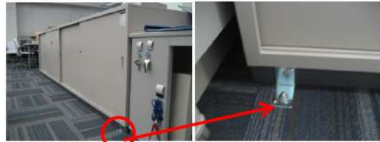
図11 キャビネットの固定
