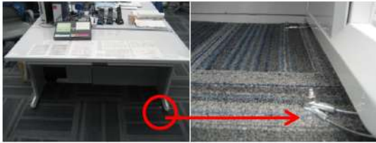
図10 運転員机の固定
