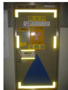
図 16 扉への反射テープ貼り付け例
