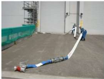
可搬型ホース敷設 （屋外）
