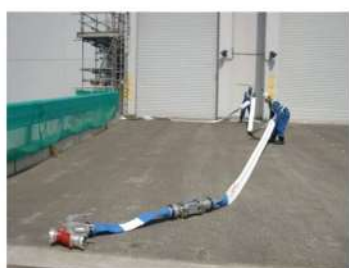
可搬型ホース敷設 （屋外）
