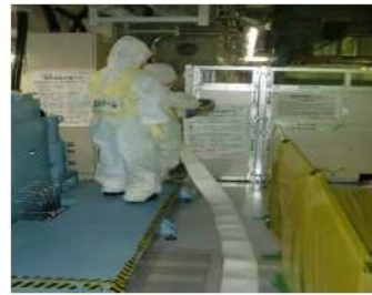
可搬型ホース敷設 (燃料取扱棟 T. P. 33. 1m)
