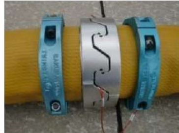
可搬型ホース(150A)接続後
