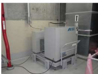
監視カメラ空冷装置
