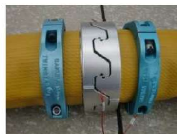
可搬型ホース(150A)接続後
