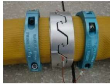
可搬型ホース（150A）接続後
