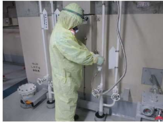
(制御用空気供給弁閉操作イメージ)
