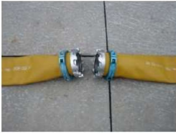
可搬型ホース（150A）接続前
