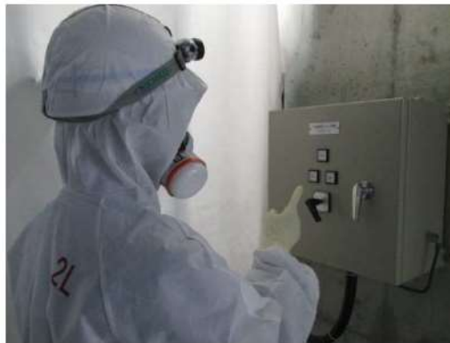
代替格納容器スプレイポンプ起動操作 （周辺補機棟 T.P. 10.3m）
