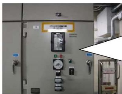
【図2 SA用代替電源受電B系 受電遮断器】
